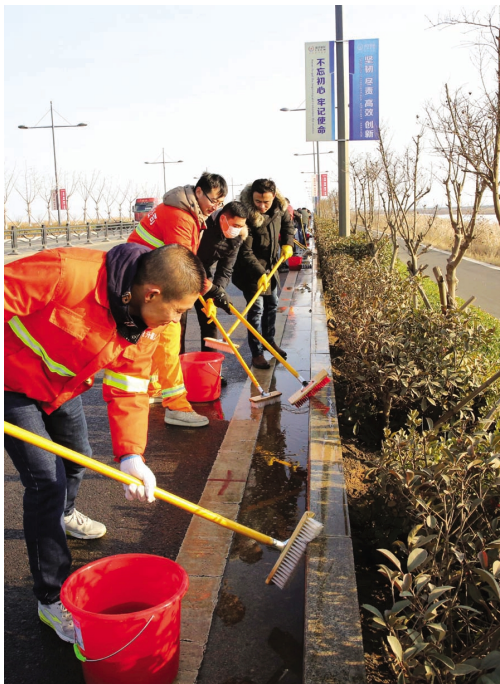
12月6日—14日,徐圩悦升公司上下同心,携手奋战,为做好江苏省重大项目开工仪式市政绿化保洁“大保障”工作,高效完成道路坑塘维修7000平方米、海滨大道除锈上漆20000平方米、路灯杆扶正26根、护栏冲洗24千米、挡浪墙冲洗15千米等工程,得到新区领导及主管单位肯定。
