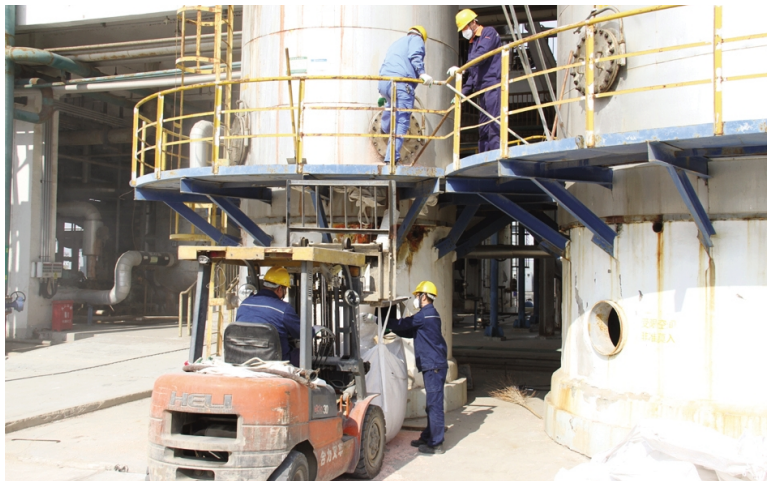
10月15日,利海化工公司为期7天的大修正式开始,面对大修工作量大、时间紧、任务重、作业点多等难题,该公司层层落实责任,确保对双氧水、氯化苯、苯甲酰装置、成套机组和仪表5个大类29个项目维护保养顺利完成。(利海宣)
