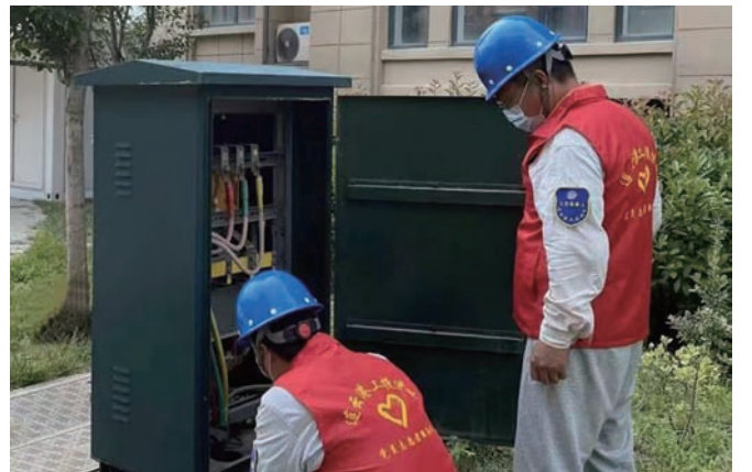
日前,供电工程分公司徐南供电所组织“盐电先锋”党员服务队奋战在“疫”线,第一时间参与辖区疫情防控工作,为徐圩幸福家园疫情防控检测点快速送上“放心电”,以实际行动践行供电党员的初心和使命。(周国成 邱利益)
